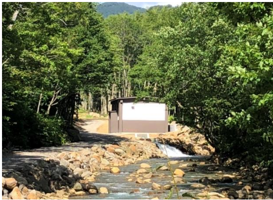
<発電所建屋（鶴の湯）>
